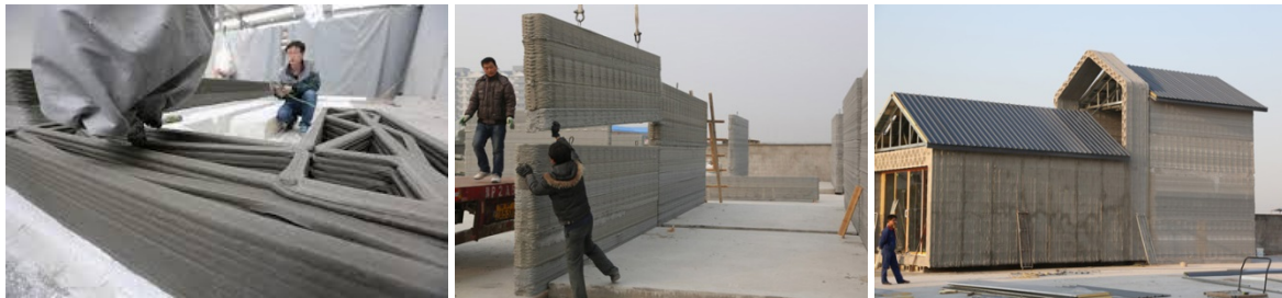
Chinese Matériau, (méthode par dépôt sélectif)
