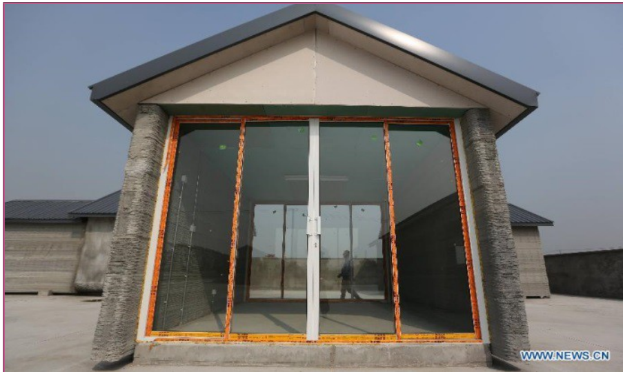
Une des dix maisons faite par l'imprimante 3D
