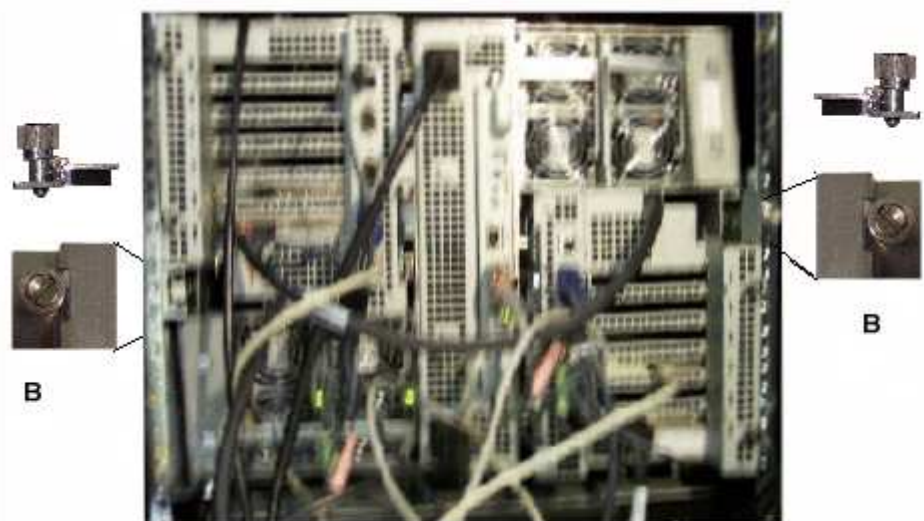
Figure 5. Installation des butées arrière
