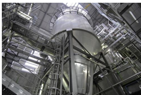
Unité de traitement des fumées et mâchefers stockés pour la filière routière
