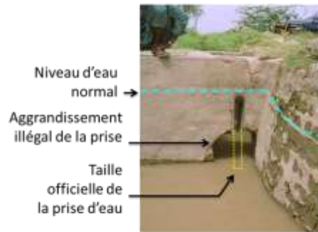
Figure 5 : Prise d'eau illégalement modifiée
