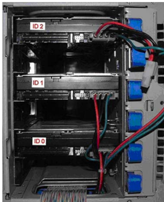
Figure 60: Trois disques durs SCSI installés
