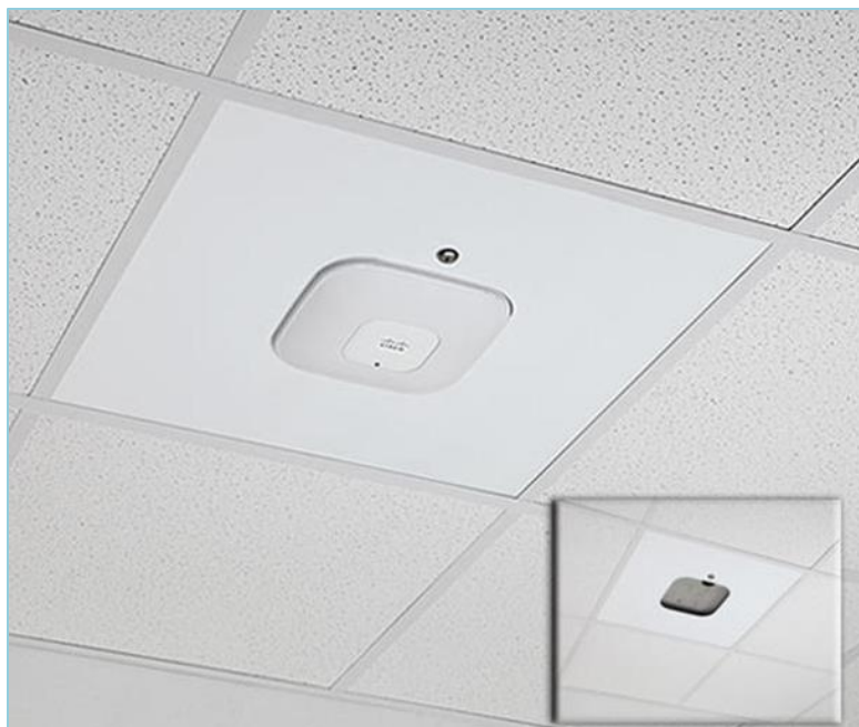
図 66. Oberon の金属製ラックはクリーンルームエリアの AP を保護し、しっかり固定する
